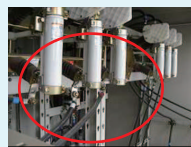
地震によりLBS端子部変形
