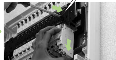
③指をA部にかかけ、ブレーカを引きながら、プラスドライバでB部を押し、ブレーカを取り外す。 ※プラスドライバは、2番または3番。 ※ブレーカの脱落に注意してください。
