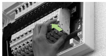
②ロックレバーを引き上げるようにスライドさせてロックを外す。
