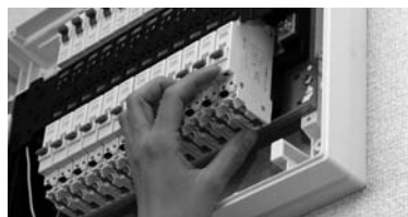
①取り外すブレーカのロックレバーに指をあてる。
