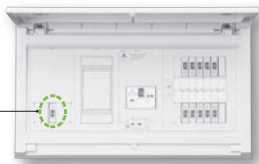
エコキュート・電気温水器用ブレーカ
