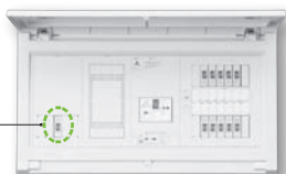
エコキュート・電気温水器用ブレーカ
