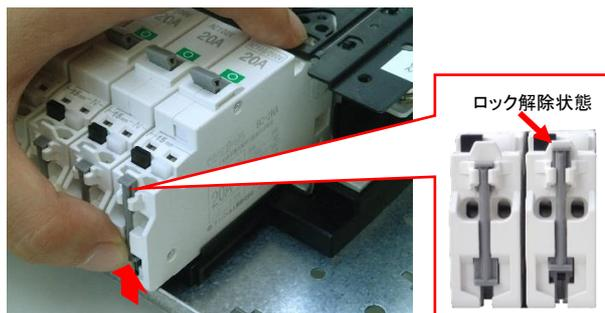
ブレーカ(A部)に手を添えて引きながら母線カバー部の穴(B部)をプラスドライバーで押し、ブレーカを取り外します。
